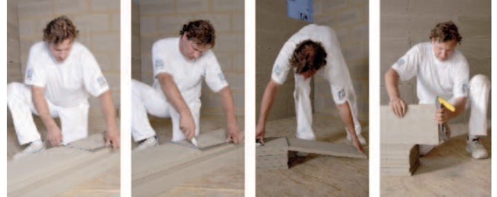
On trace la ligne de découpe avec l'aide d'une équerre / On vient rainurer la plaque en 2-3 coups de cutter / La plaque peut être rompue facilement au niveau de la rainure / On vient lisser le bord avec un rabot
